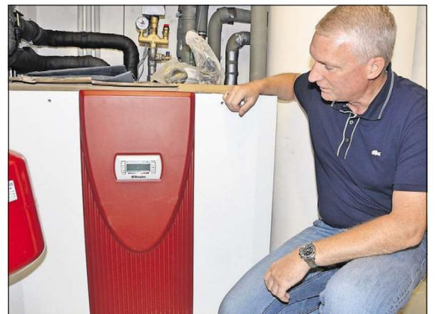
**Innovative Technik:** Geheizt wird mit Erdwärme. Ein Gasanschluss ist deshalb nicht nötig. Die thermische Energie wird aus 99 Meter Tiefe gewonnen.
