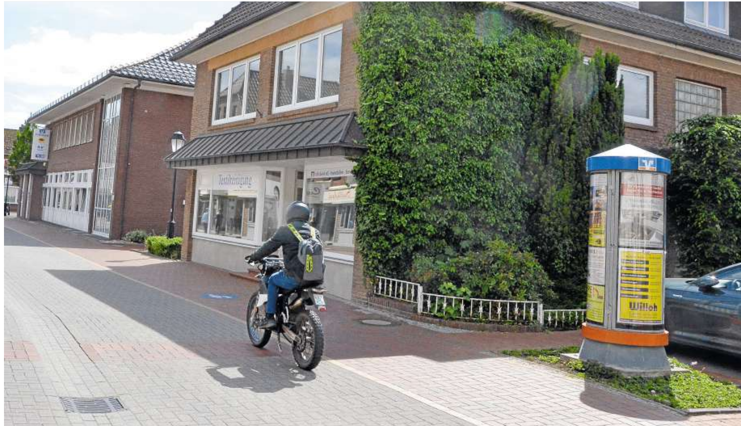
Vor dem Abriss: Das ehemalige Wäschereigebäude soll durch einen Neubau ersetzt werden. Die Volksbank will hier ein dreieinhalbgeschossiges Wohn- und Geschäftshaus bauen.
